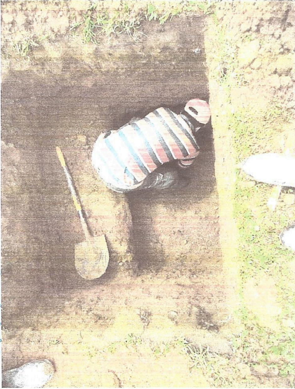
Trabajos en las perforaciones
